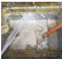
③汚泥の洗浄。
