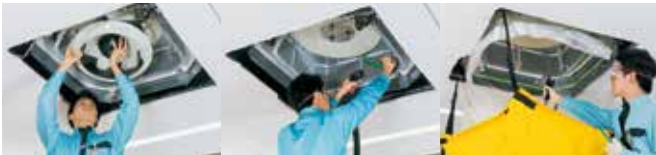
1 分解 2 ホコリの除去 3 内部クリーニング
